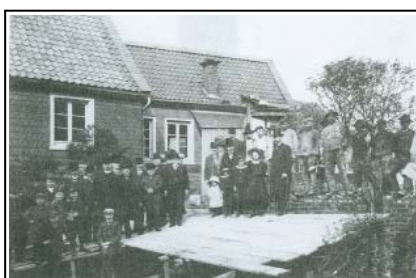
1902: Die Grundsteinlegung für das Pastoratsgebäude in der Neustraße . Ein Konfirmandensaal wurde 1905 angebaut. Pfarrer Otto Köhne bezog mit seiner Familie zuerst den Neubau.
