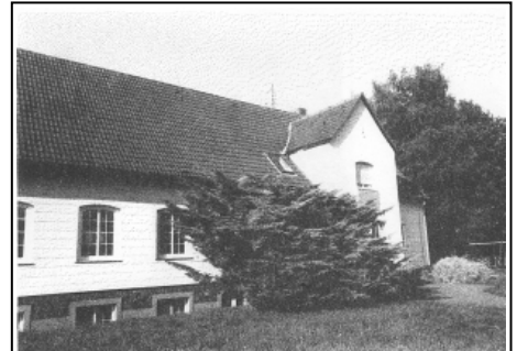
Das Gemeindehaus Heide . Links der Gottesdienstraum, rechts das Pfarrhaus und im Untergeschoss Gruppenräume
